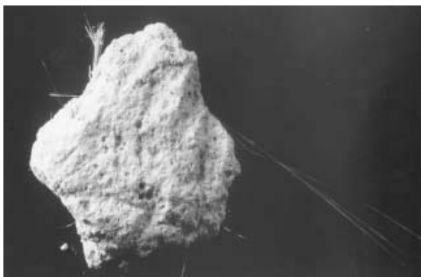
Mörtel aus einer asbesthaltigen Rohrisolation mit sichtbaren Asbestfaserbüscheln, Foto: SA
