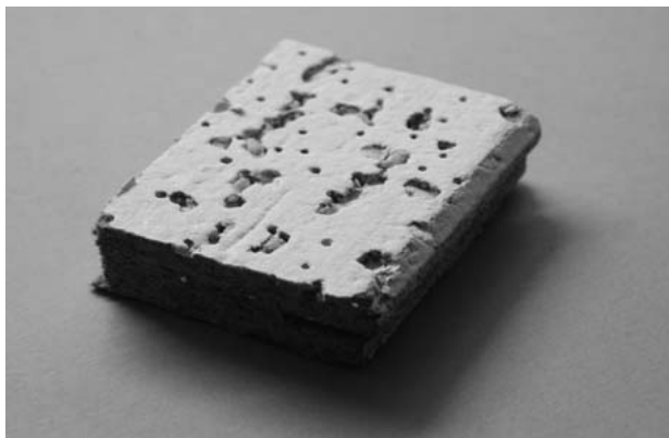
Teil einer asbesthaltigen Akustikplatte, Foto IST
