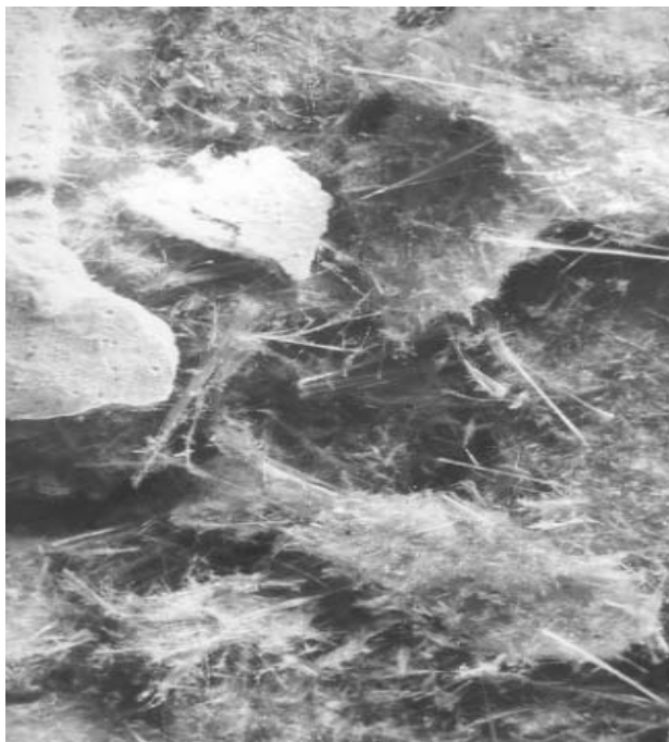
Vergrosserung eines Spritzasbestbelags mit Fasern aus Mineralwolle und spitzen Asbestfaserbüscheln, Foto: SA
