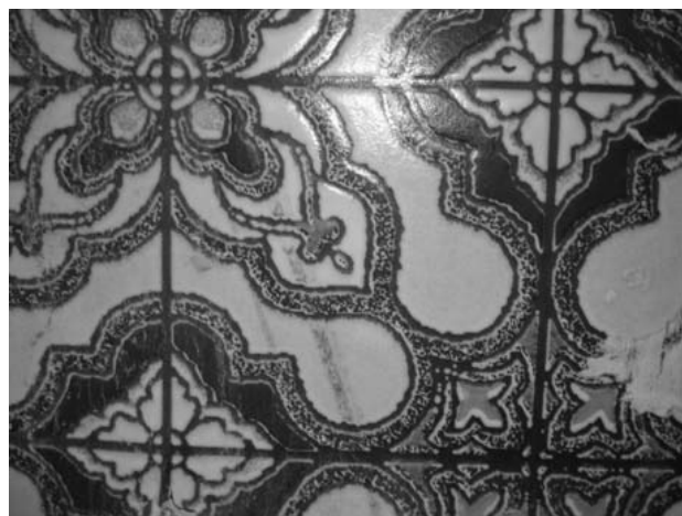
Dreischichtiger Bodenbelag mit Asbestpappe, Foto: Carbotech AG
