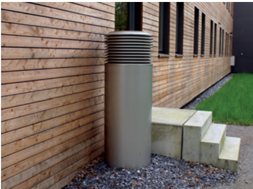
Ansaugöffnung für kontrollierte Wohnraumlüftung (mindestens 80 cm über Boden)
