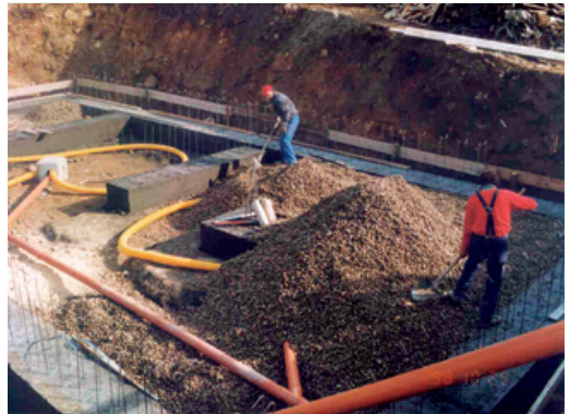
Einbau einer Radondrainage in Kies beziehungsweise Schotter
