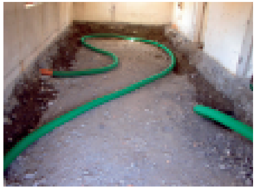
Erneuerung des Fußbodenaufbaues: Einbau einer Radondrainage.
