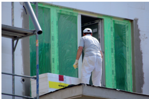
Sanierungen beeinflussen die Dichtigkeit der Gebäudehülle.
