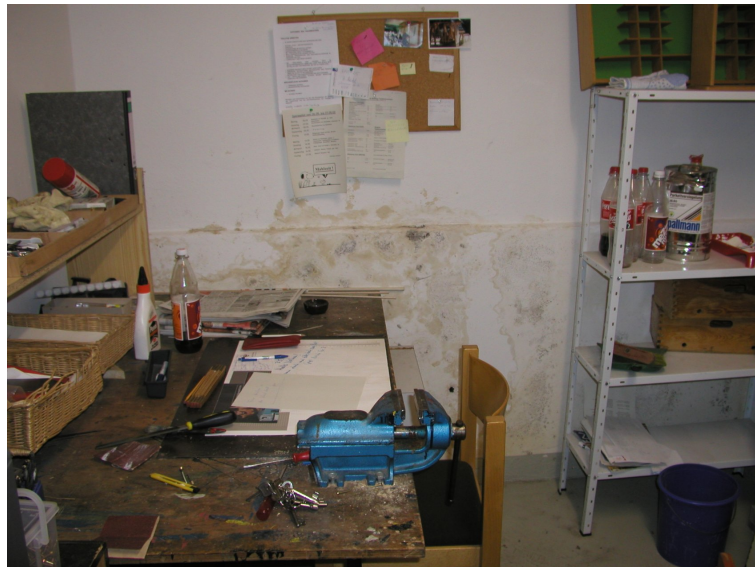
Befallene Putzoberflächen in einer Hausmeisterwerkstatt
