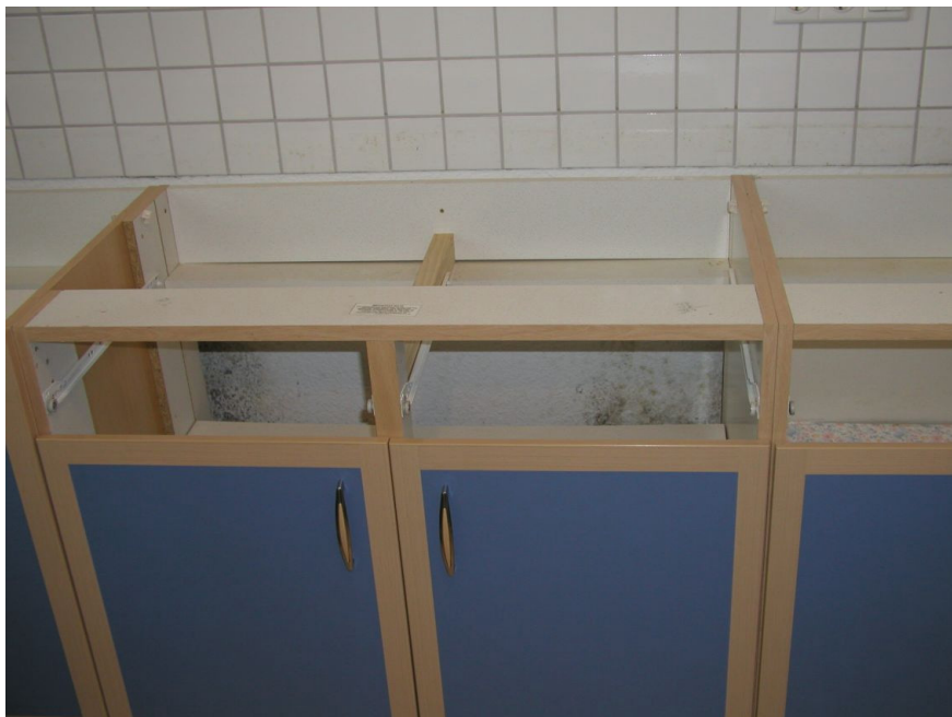
Kritischer Bereich: Schimmel in der Küche einer Hausmeisterwohnung hinter der Küchenzeile
