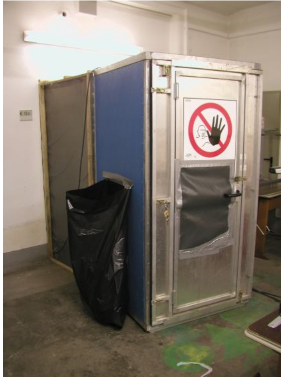
Schleuse zur Abschottung einer Schimmelsanierung
