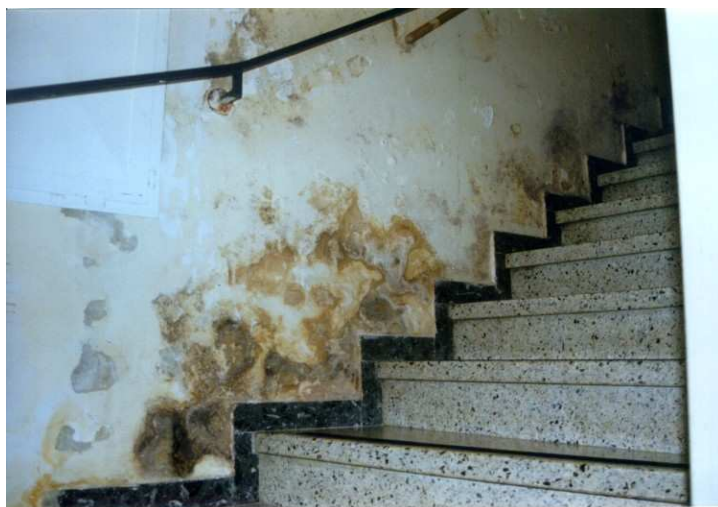
Abbildung 1: Typisches Schadensbild kapillar aufsteigender Feuchte
